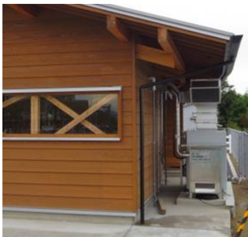
中和消臭器 VFD-1020NO (特別仕様) 現場：新潟県
